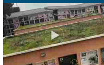
Frana cimitero di Camogli, bare in acqua: il momento del crollo
